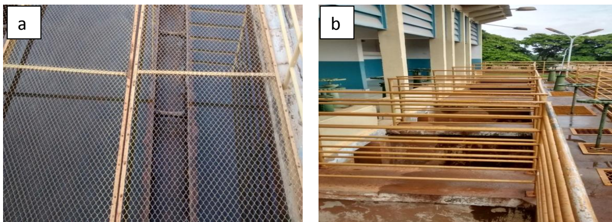
Figura 2. (a) Decantadores com colméias de fibra de vidro, (b) Filtros do tipo rápido.
